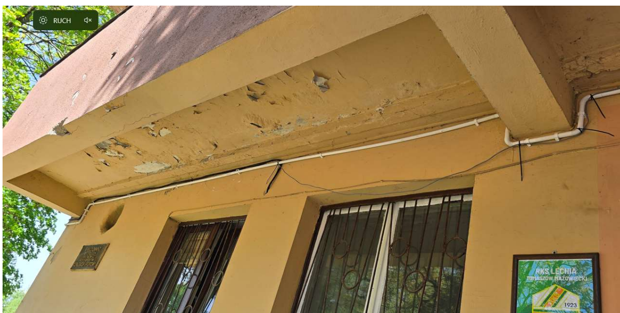
Zd.23 Widok uszkodzeń spowodowanych wilgocią
