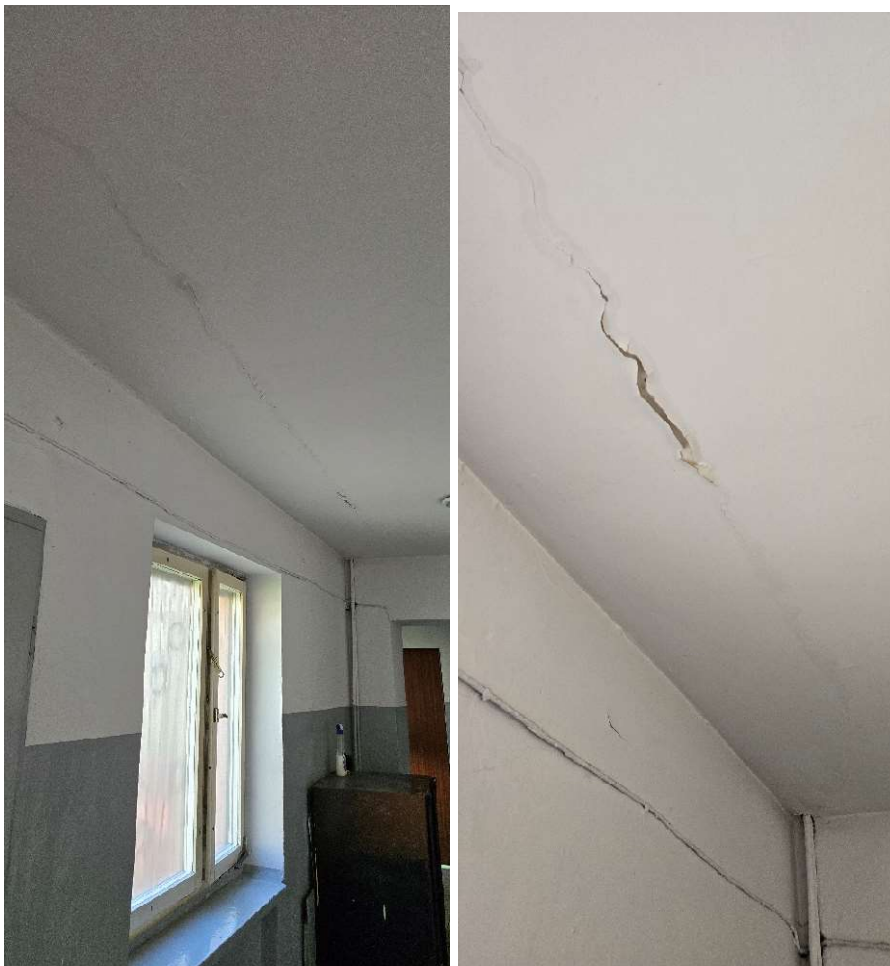
Zd.14 Widoczne podłużne zarysowanie wraz z odspojeniem tynku
