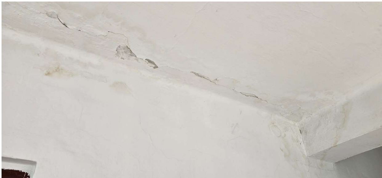
Zd.12 Widoczne odspojenie tynków spowodowane zawilgoceniem
