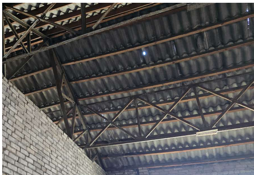
Zd.21 Widok nieszczelności w pokryciu
