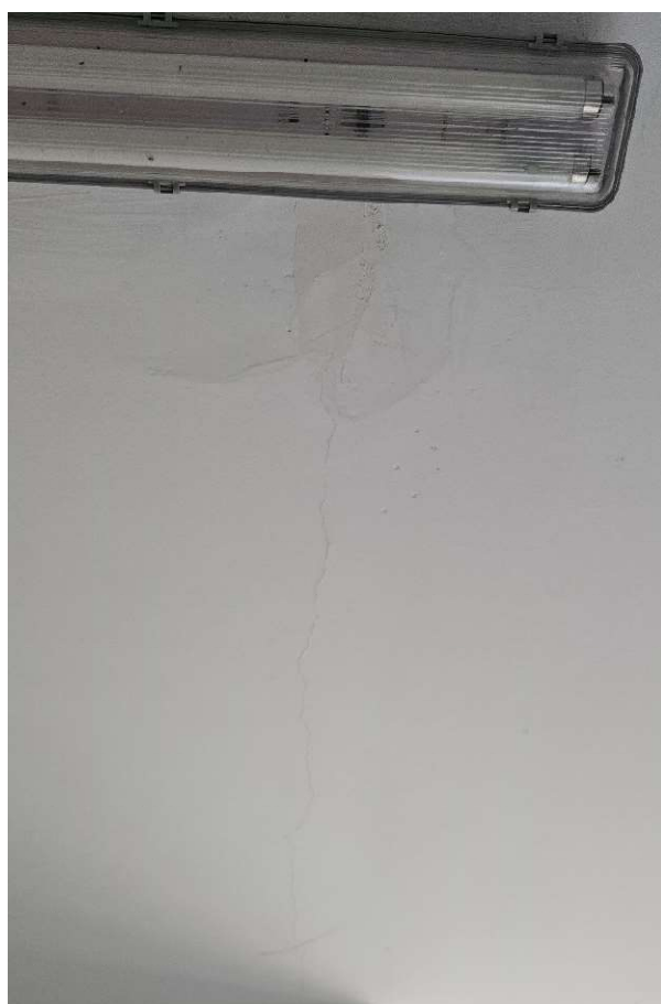
Zd.12 Widoczne odspojenie tynków spowodowane zawilgoceniem
