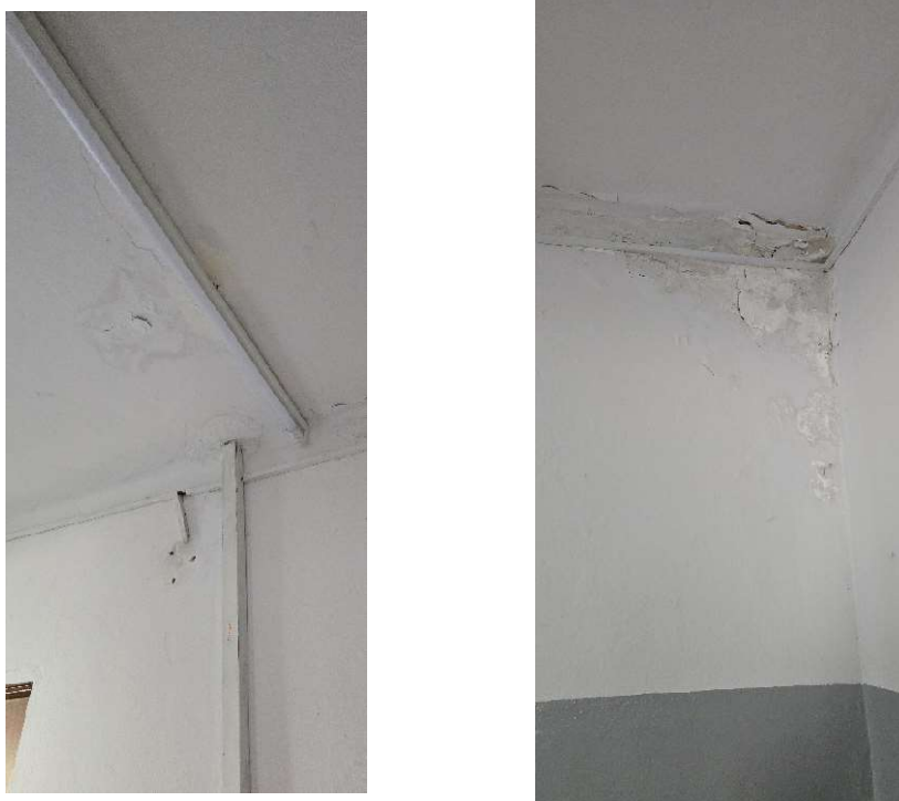
Zd.15 Widoczne zawilgocenia sufitów
