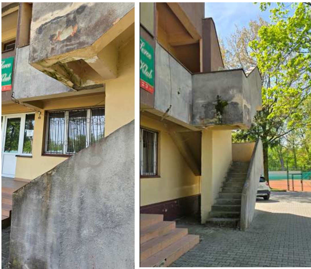
Zd.26 Widoczne zawilgocenie ścian balustrad
