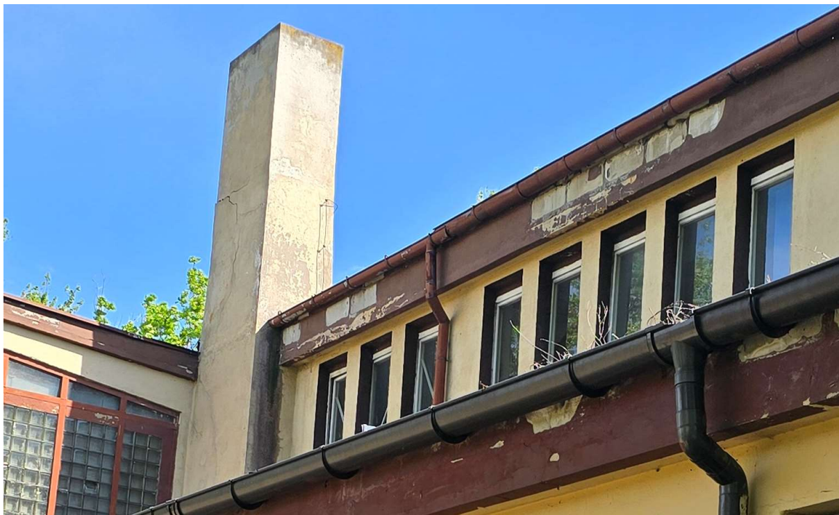
Zd.18 Odłonięte i niezabezpieczone elementy murowe w pasach nadokiennych.
