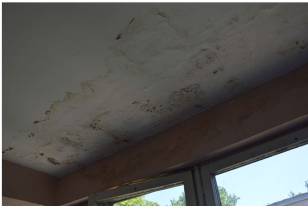
Zd.16 Widoczne zawilgocenia sufitów w wyniku nieszczelności pokrycia dachowego
