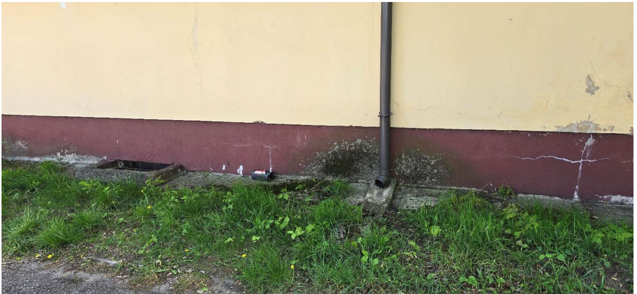
Zd.6 Zawilgocenia ściany w okolicach rynien spustowych. Drobne pionowe ryski na tynkach.
