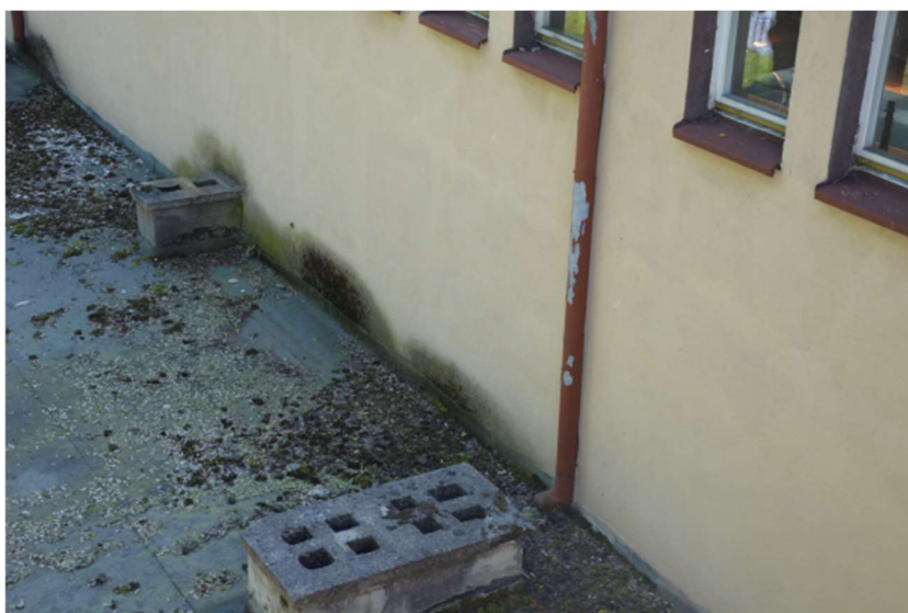
Zd.17 Nieprawidłowo wykonane obróbki skutkują podciąganiem wody przez ściany murowane
