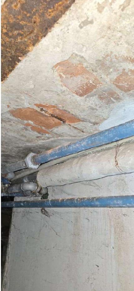
Zd.11 Widok wypełnienia ceglanego stropu oraz skorodowanej belki stalowej
