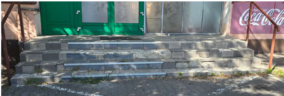
Zd.27 Widoczne uszkodzenia schodów zewnętrznych
